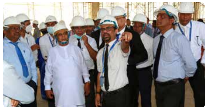
ගුවන් භාණ්ඩ බහාලුම් ගම්මානයේ පිවිසුම් / පිටවීමේ ගොඩනැගිල්ල ඉදිකිරීම
